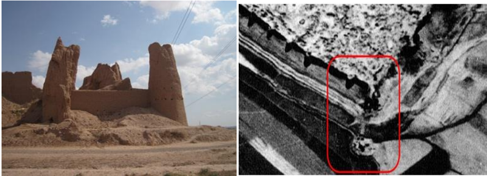
شکل ۳- موقعیت دروازه ی جنوب غربی ارگ، خندق و برج نگهبانی (اشمیت، ۱۳۷۶)- بقایای
